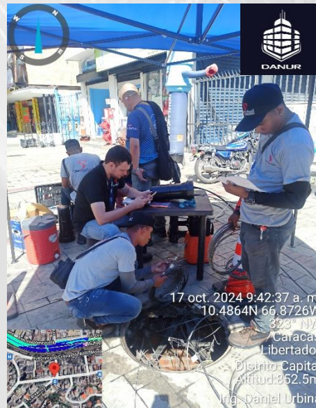
Procedimiento del pase de hilo guía y empalme en mangas
