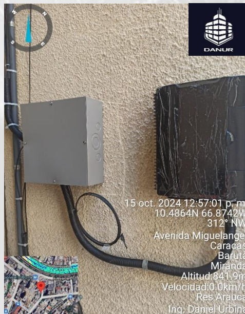
Instalación de Cajas Nap y Reservas
