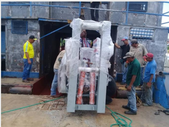
Instalación del Motor Propulsor
