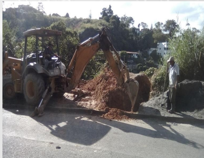
Excavación para colocación de Bocas de visita
