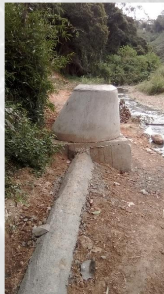
Embonado de tuberías y Construcción de Bocas de Visita
