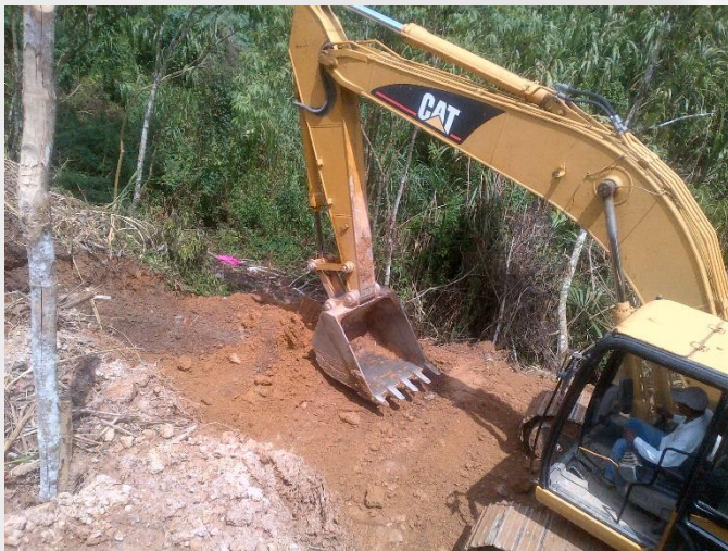
Excavación para colocación de tuberías
