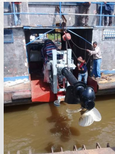
Ubicación del Motor Propulsor con Hélice previamente instalada
