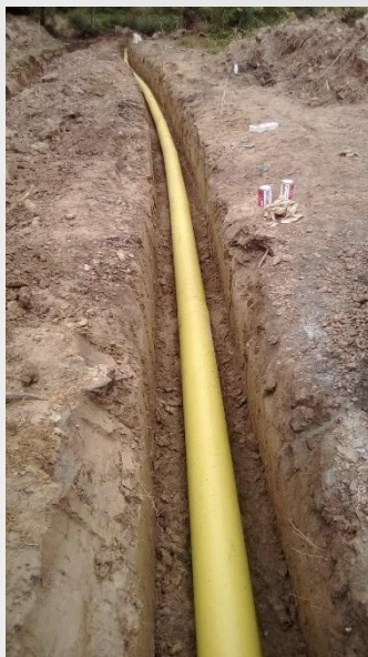
Colocación de tuberías de PVC
