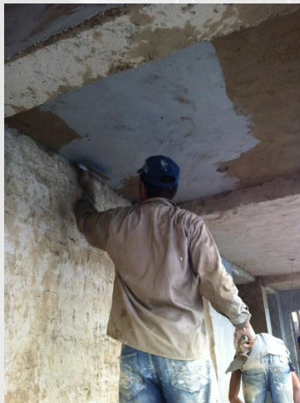
Proceso de Friso en Paredes en Liceo Rosalía Campins.
