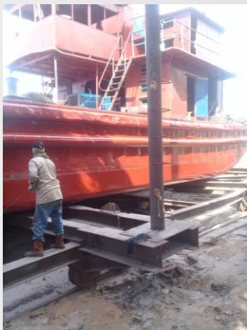
Aplicación de Pintura del Casco
