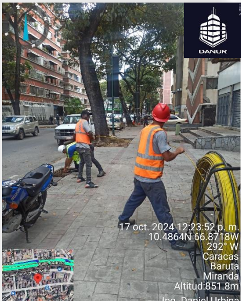
Procedimiento del pase de hilo guía y empalme en mangas
