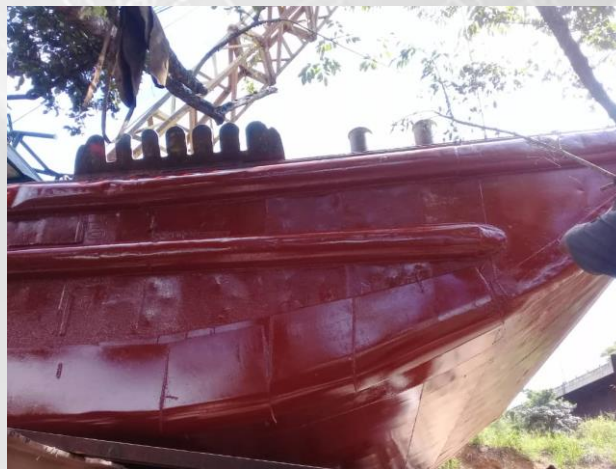
Aplicación de Pintura en el Casco
